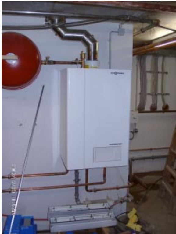
Abbildung 37: Das verwendete Gas-Brennwertgerät; es versorgt beide Gebäudeteile mit Heizwärme und Warmwasser; gut erkennbar sind die Anschlüsse der noch ungedämmten, warmen Heizwärmeleitungen sowie oben das Leitungsstück zum Druckausgleichsgefäß und die Abgasleitung.
