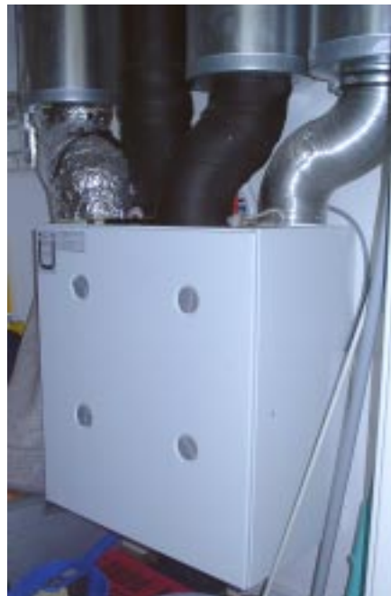
Lüftungsgerät mit Wärmerückgewinnung im Abstellraum einer Wohnung
