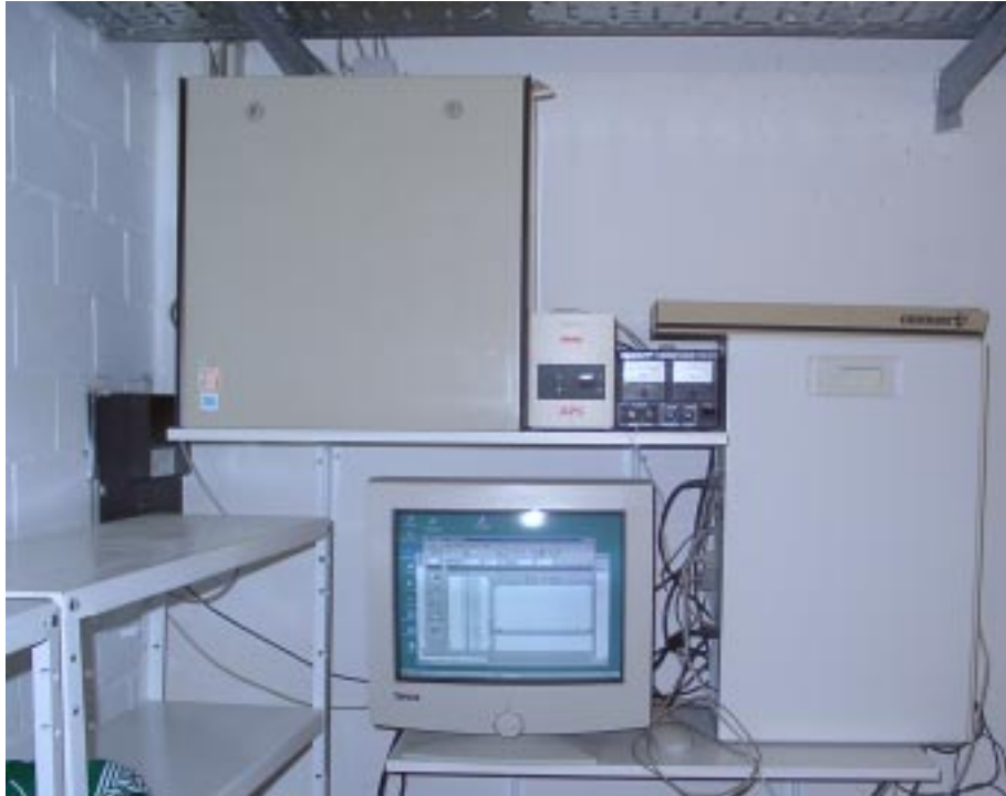
Abbildung 45: Messtechnik-PC im Technikeller mit dem Schaltschrank der Wetterstation, Spannungsversorgung der Sensoren und dem M-Bus-Master.
