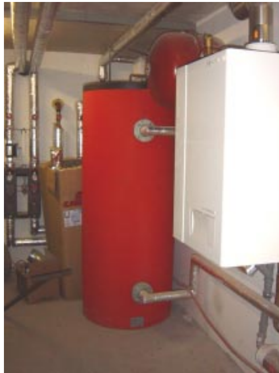
Abbildung 51: Wandhängender Gas-Brennwertkessel und dahinter der Warmwasserspeicher zur zentralen Wärmeversorgung (Heizung/Warmwasser) im Keller.
