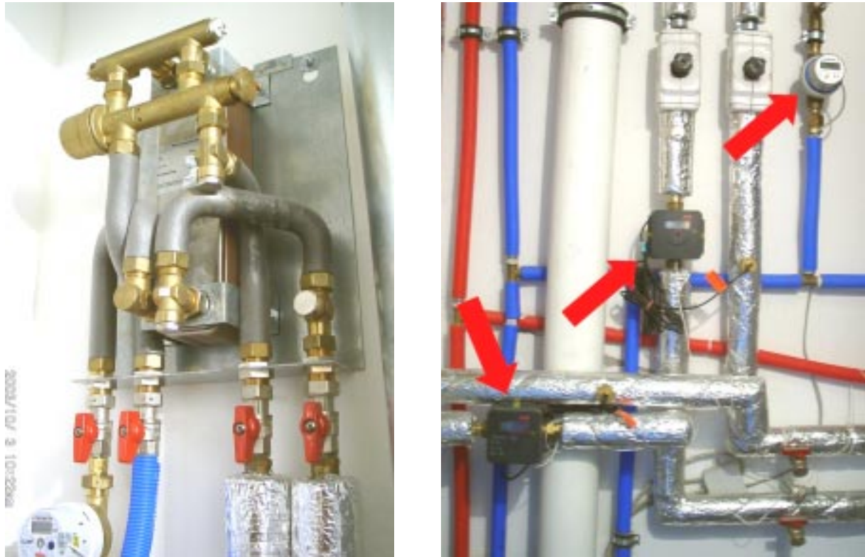
Abbildung 56: Konsole mit Plattenwärmeübertrager in einer Wohnung zur Warmwasserbereitung (links) und die beiden Wärmemengenzähler und der Kaltwasserzähler in einer Wohnung von Haus B.
