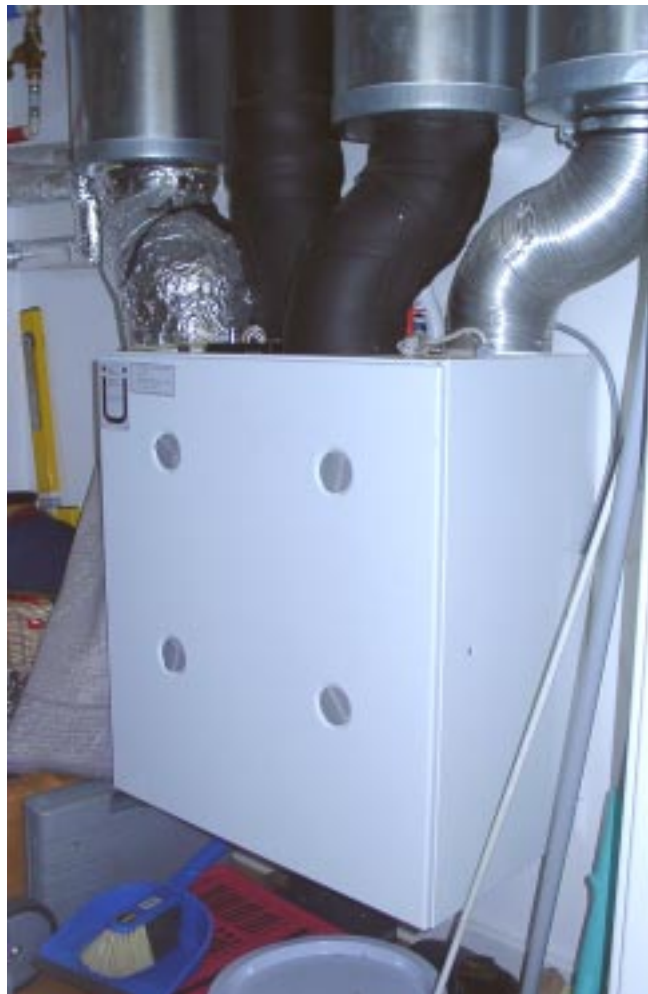
Abbildung 14: Lüftungsanlage mit Wärmerückgewinnung im Abstellraum einer Wohnung.
