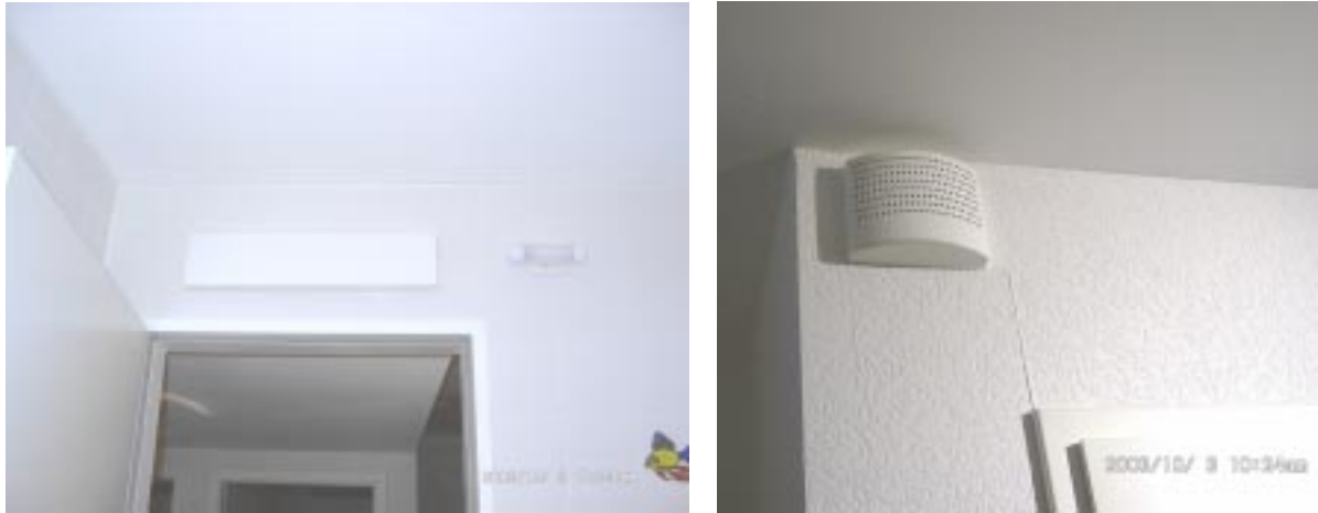
Abbildung 16: Überströmöffnung (links) und Zuluftelement (rechts) in einer der Wohnungen
