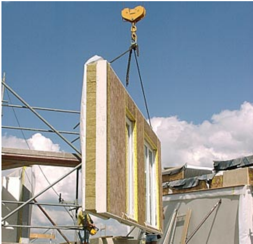
Abbildung 4: Ein Fassadenelement mit Superdämmung und bereits eingebauten Fenstern am Kran; im Hintergrund bereits montierte Dachelemente (Foto: Feist; Elemententwicklung: Rasch, faktor 10).
