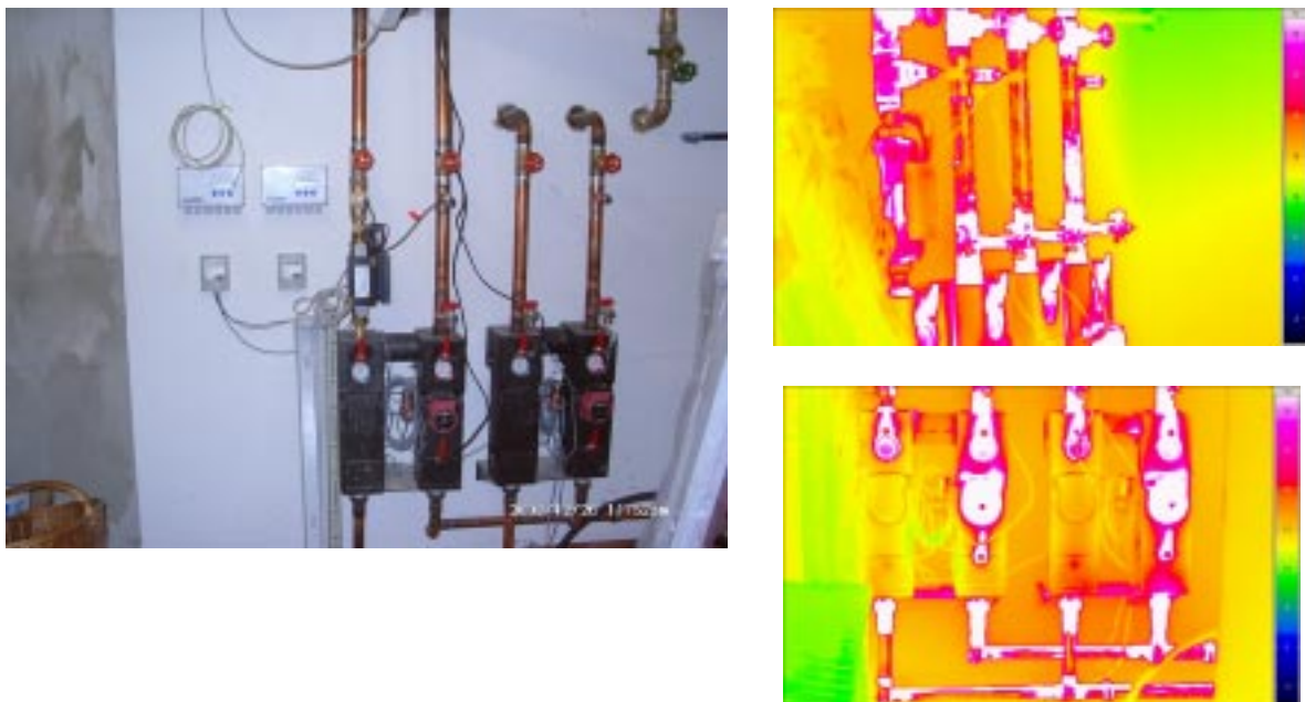
Abbildung 39: Pumpengruppe und noch ungedämmte Rohrleitungen im Heizungskeller
