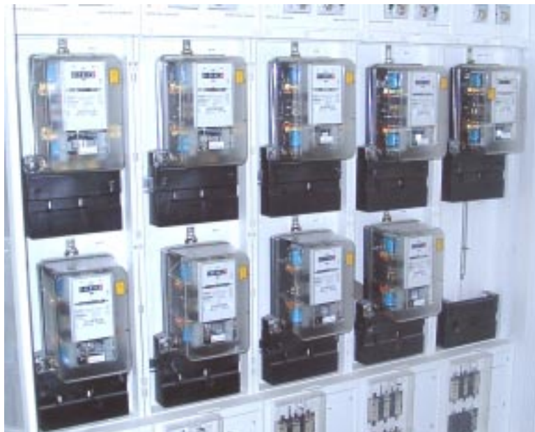
Abbildung 53: Zählerfeld mit Haushalts-Stromzählern im Technikeller
