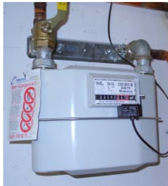
Abbildung 52: Die Rechenwerke der beiden zentralen Wärmemengenzähler für Haus A und B (links) und der Gaszähler mit Niederfrequenz-Impulsgeber (rechts)
