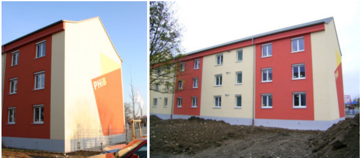
Abbildung 15: Giebelwand (West) und Nordfassade des PHiB kurz vor Bezug der Wohnungen.
