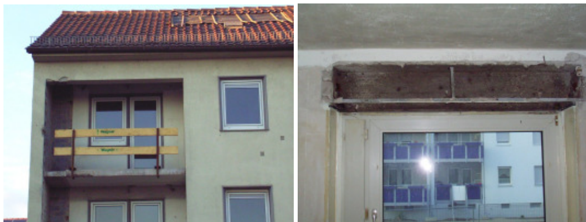
Abbildung 6: Links : Die Entfernung der auskragenden Balkonplatte ist erfolgt. Rechts : Der alte innenliegende Rollladen über dem Fenster wurde entfernt. Die Rollladenkästen stellen immer eine große Wärmebrücke und eine große Undichtheit dar. Später wurden fassadenbündig außenliegende Rollläden montiert.
