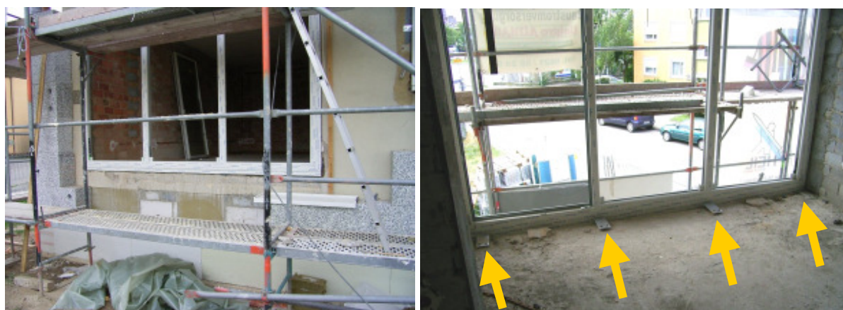
Abbildung 7: Montierte neue Fensterrahmen im Bereich des ehemaligen Balkons (jetzt Wohnzimmer). Von innen sind die massiven Lastabtragungswinkel sichtbar (Pfeile).
