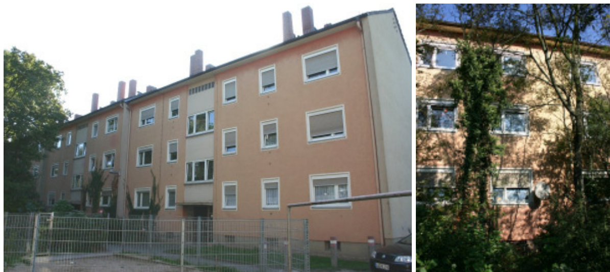
Abbildung 133: Links: Westlicher Teil der Nordfassade des unsaniertes Wohngebäudes in der Nähe der Hoheloostraße mit sehr ähnlicher Bauweise. Es dient bei der Untersuchung als Referenzgebäude. Rechts: Teil der verschatteten Südfassade des Gebäudes.
