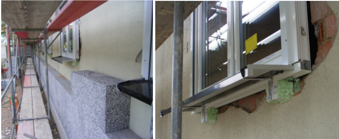
Abbildung 8: 300 mm Dämmstoffblöcke an der Nordfassade des PHiB sowie Fenster- und Fensterbankmontage.
