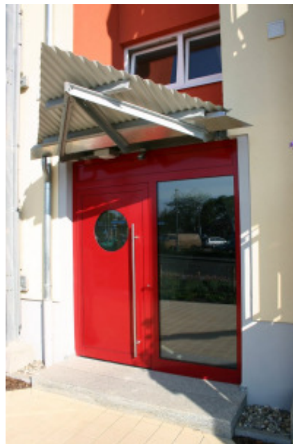
Abbildung 18: Eingangsbereich des NEH mit Vordach.
