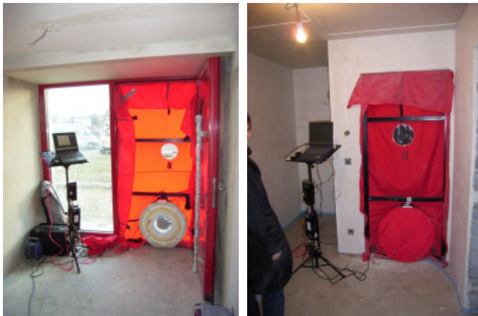
Abbildung 31: In der Haustür (links) und in einer Wohnungstür (rechts) eingebaute Blower Door mit der zugehörigen Messeinrichtung.
