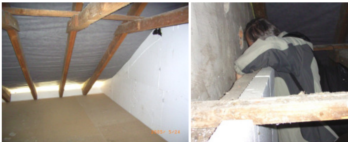
Abbildung 10: Links : Anschluss der Fassadendämmung an die Dämmung auf dem Fußboden des Dachbodens im PHiB und an der Innenseite der Giebelwand hochgezogene Dämmung. Die Giebelwände sind durchgehend auch von außen gedämmt. Rechts : Kontrolle am Abschluss der hochgezogenen Giebelwanddämmung.
