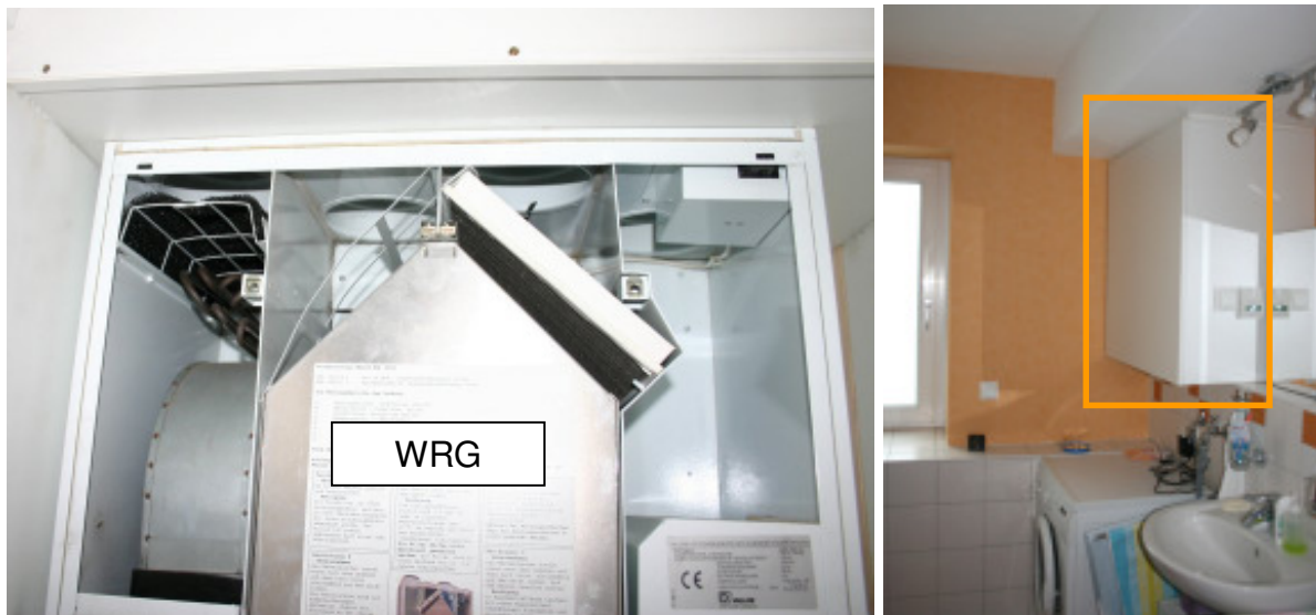
Abbildung 23: Links : Geöffnetes Lüftungsgerät mit dem zentralen Wärmeübertrager (WRG), links dem Außenluftventilator sowie den Luftfiltern (einer ist demontiert). Rechts : Lüftungsgerät in der schallgedämmten Einhausung in einem der Badezimmer zwischen Spiegel und Außenwand.
