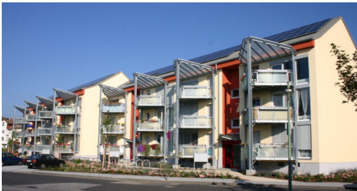
Abbildung 3: Gebäude nach erfolgter Sanierung (Südfassade).
