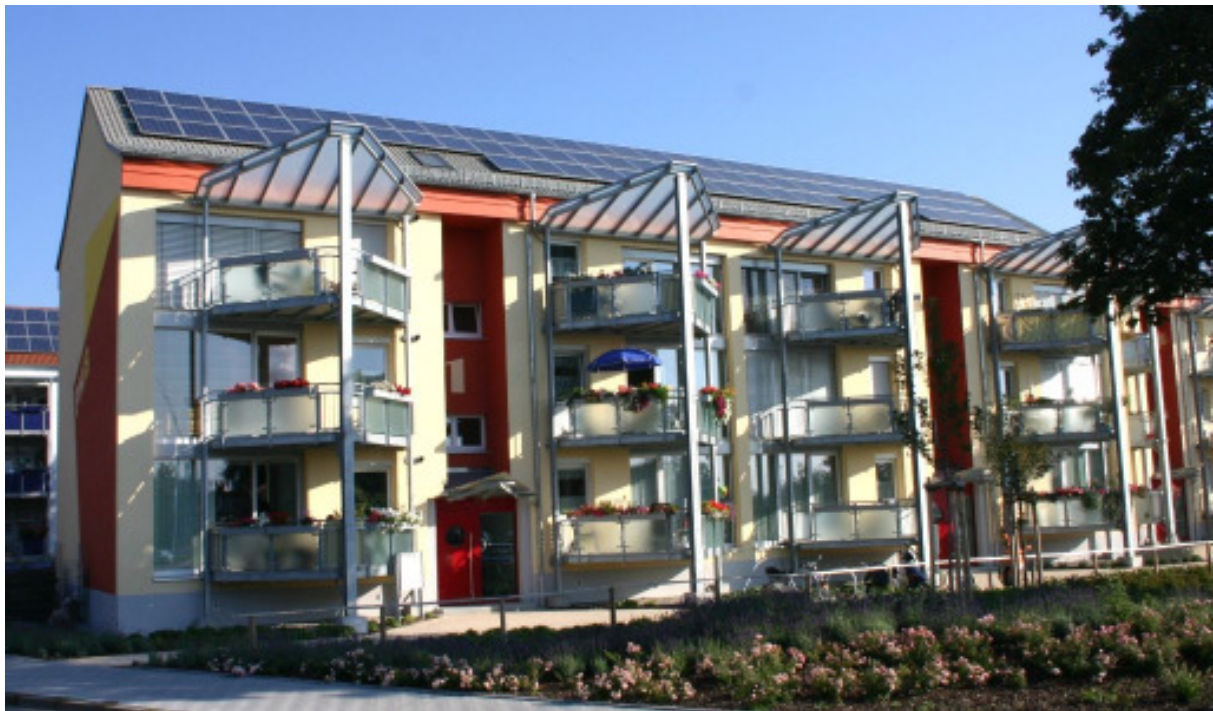
Abbildung 14: Südfassade des PHiB mit der vorgestellten Balkonanlage und der Solarstromanlage auf dem Dach.
