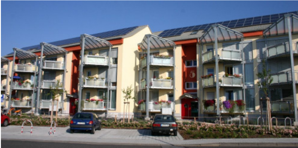
Abbildung 152: Solarstromanlage auf den Süddächern beider Gebäude.
