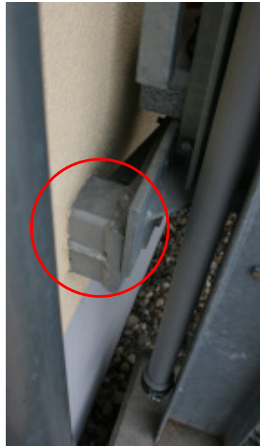
Abbildung 93: Balkonbefestigungspunkt (Balkonanker) im EG neben einer Haustür.
