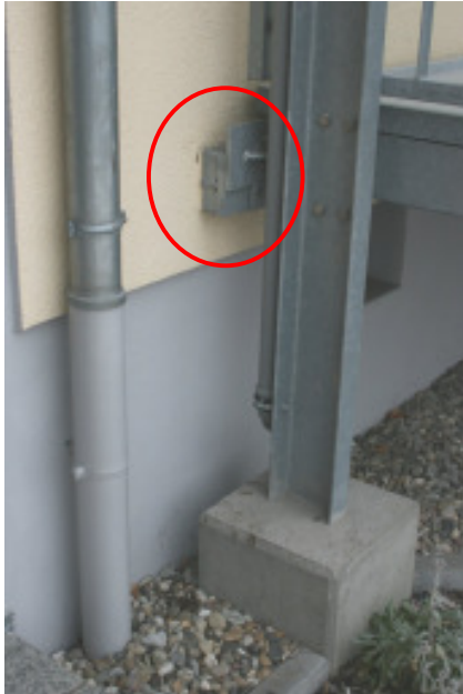
Abbildung 93: Balkonbefestigungspunkt (Balkonanker) im EG neben einer Haustür.
