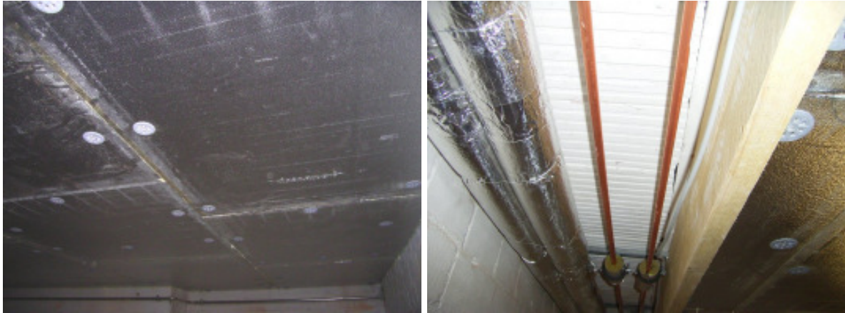
Abbildung 13: Links : Dämmung der Kellerdecke mit alukaschierten Dämmplatten. Rechts : Unterbrechung der Dämmung wg. der Rohrleitungsführung. Diese wurden später mit in die Dämmschicht einbezogen.
