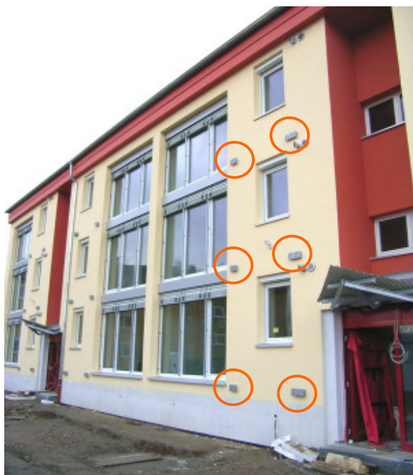
Abbildung 12: Massive Balkonankerplatten vor Montage der Balkone (links für eine Hauseingangsseite mit Kreisen markiert).
