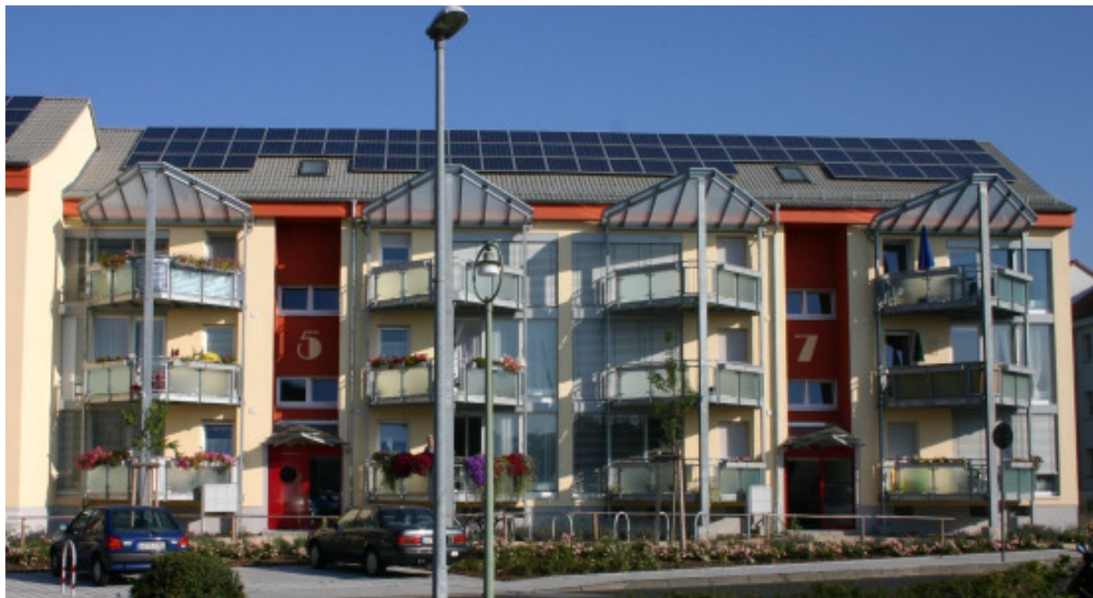
Abbildung 16: Südfassade des NEH mit Balkon- und Solarstromanlage.
