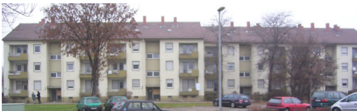
Abbildung 2: Altbauzustand der beiden Gebäude im Dezember 2004 (Südfassade).
