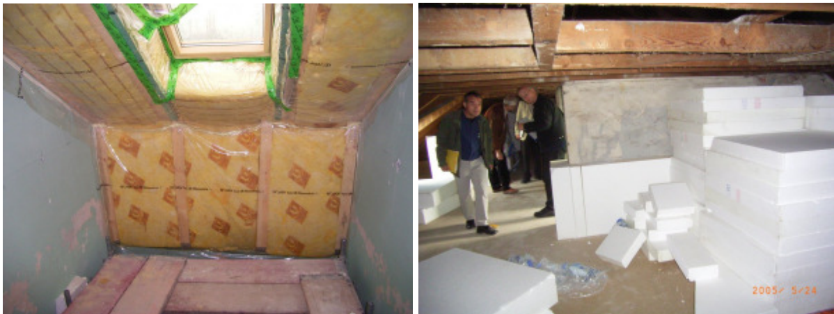
Abbildung 9: Montage der Innendämmung im Treppenhauskopf des PHiB (links) und Dämmung des Treppenhauskopfes vom Dachraum aus (rechts).
