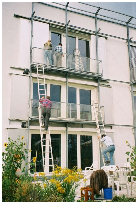
Abbildung 24: Installation der wärmegeprägten Schiebeläden im westlichen Endhaus der Zeile. Die Schiebeläden wurden von K.-H. Fingerling konzipiert (vgl. [Feist 1995b]).
