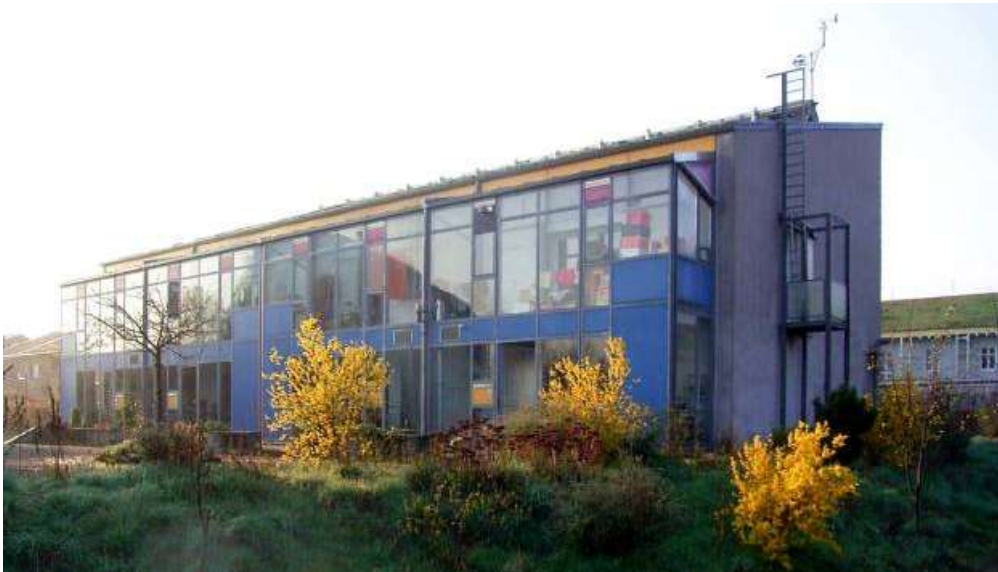
Abbildung 6: Aufnahme Passivhaus Darmstadt Kranichstein von Nordosten ; Eingangsbereich und Kellertreppen werden durch einen Glasvorbau geschützt. Hier sind in Höhe der Decke über dem EG die Luftansauggitter der vier individuellen Lüftungsanlagen erkennbar
