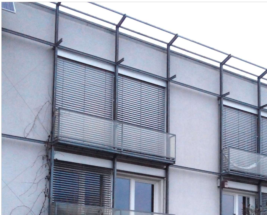
Abbildung 63: Anschluss Außenwand/Dach zugehöriges visuelles Bild. Zu beachten sind auch die unterschiedlichen Jalousie-Stellungen, die im thermischen Bild kontrastreich hervortreten. Der Wärmestrom wird bei geschlossener Jalousie zu einem bedeutend höheren Umfang durch Konvektion abgeführt.
