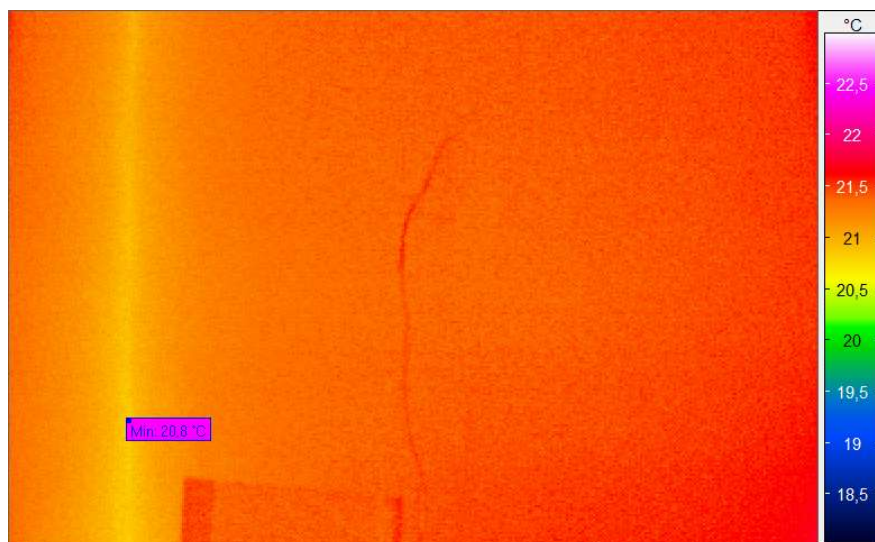
Abbildung 78: Thermogramm aus dem Arbeitszimmer, dem Raum in der Dachgeschoss Nord-west-Ecke. Die operative Raumtemperatur liegt hier um 21,5 °C; in der Kante fallen die Temperaturen bis auf minimal völlig unkritische 20,8°C ab. Das Kabel im Bild ist die Zuleitung zum Oberflächentempersensoren, der unterhalb des Wärmestromsensoren angebracht ist. Überhaupt nur im hoch temperaturlösten Bild sind die Temperaturverläufe an der Außenwandkante (geometrische Wärmebrücke Außenwand Süd an Außenwand West) erkennbar.
