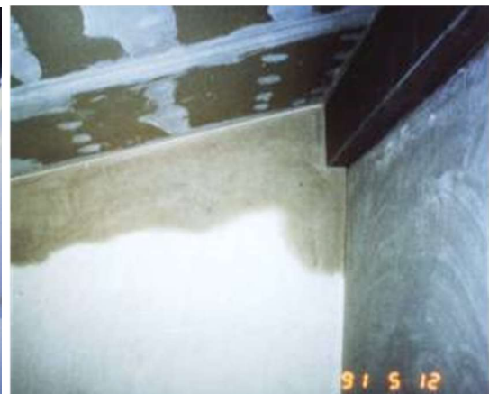
Abbildung 111: Links: Halb eingeputzte, mit Streckmetall abgedeckte PE-Folie vom Dach (1991). Rechts: Fertig verputzte PE-Folie für den luftdichten Anschluss Dach-Wand. Rechts oben im Bild der Ringanker (dunkler „Kasten“) (1991).
