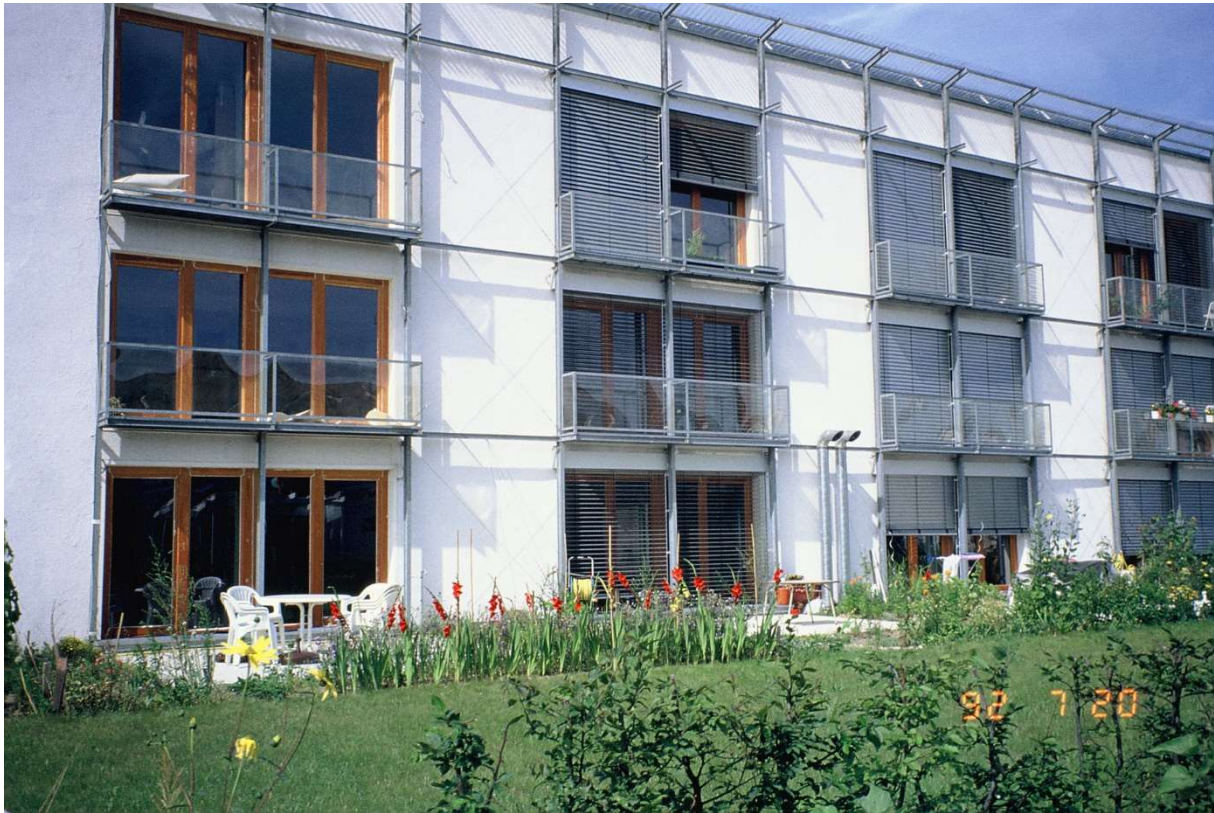
Abbildung 98: Außenansicht des Passivhauses von 1992 mit montierten, aber noch nicht lackierten Dämmschalen an den Fensterrahmen (alle Fenster in allen Wohnungen sind so ausgestattet).
