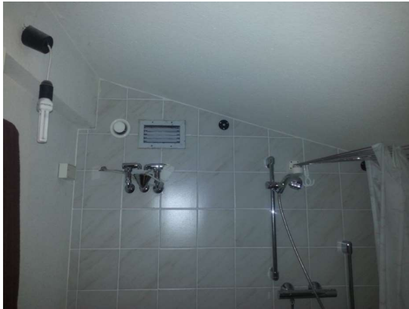
Abbildung 85: Die visuelle Inspektion zeigt auch keinen Schimmel – an keiner Oberfläche.
