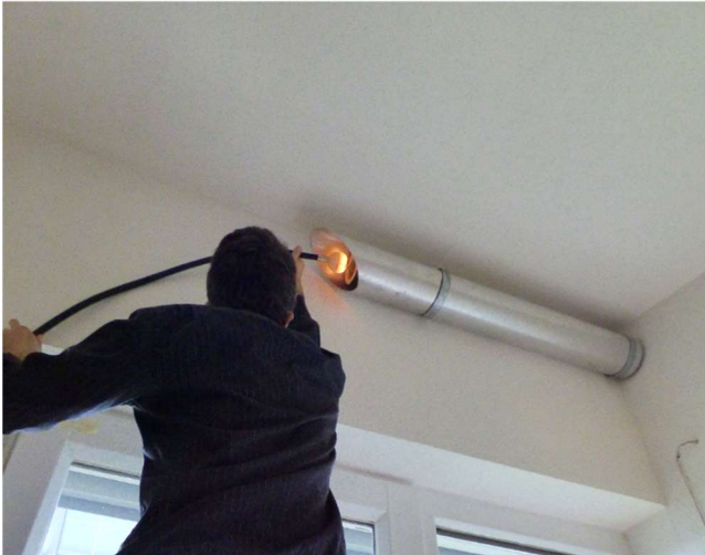
Abbildung 150: Eine Spezialkamera zur Inspektion von Lüftungskanälen (Snake-Cam) wird in ein Zuluftrohr eingeführt.
