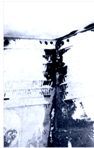
Abbildung 110: Die Bilder aus der Bauzeit zeigen die mit der Wand überlappenden Folie (links), welche mit Streckmetall abgedeckt und dann überputzt wird (rechts).
