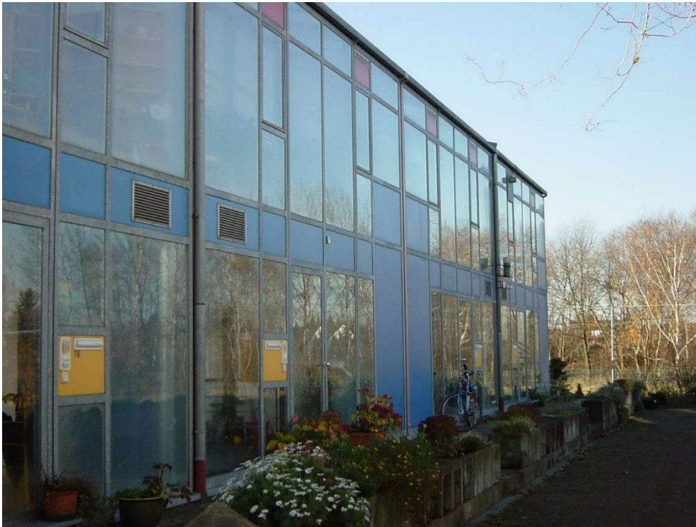
Abbildung 57: Visuelle Aufnahme: Glasvorbau auf der Nordseite; auch hier gut zu erkennen: Die Gitter der Frischluftansaugung im Obergeschoss.
