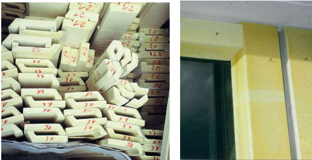
Abbildung 96: Dämmschalen vor (links) und während der Montage (rechts) an den Holzfensterrahmen. Die Konstruktion der Dämmschalen wurden maßgeblich von K. H. Fingerling entwickelt (vgl. auch [AkkP 3]).
