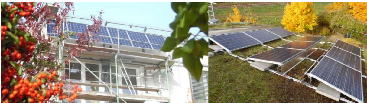
Abbildung 15: Installation der PV-Anlage 2015
