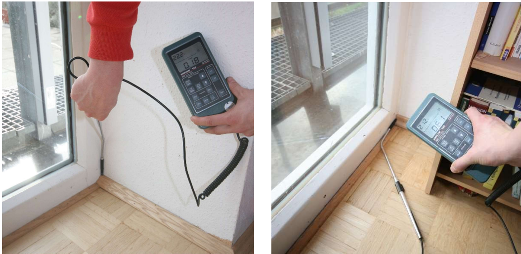
Abbildung 122: Kleine tolerierbare Restleckagen in den Ecken der Anschlusspunkte „Fenster an Betonfußboden“ bei der Blower Door Messung 2016.
