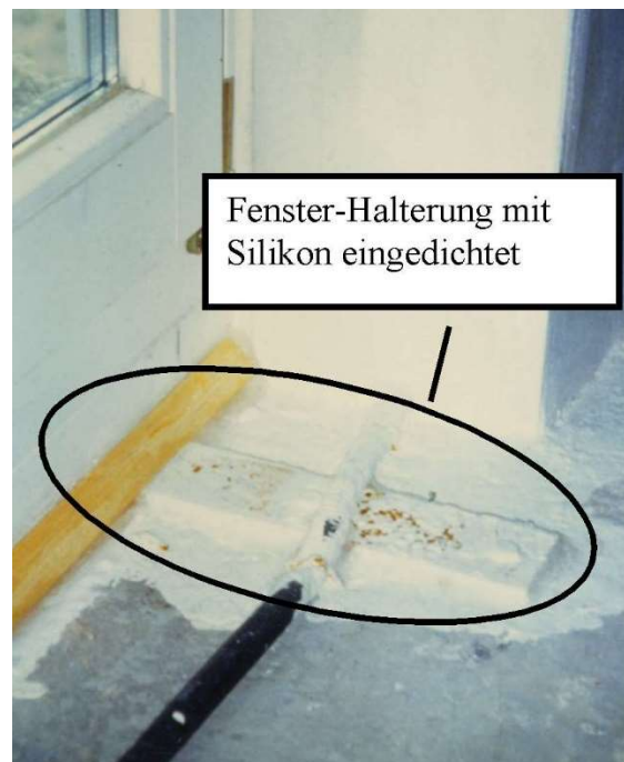
Abbildung 121: Foto vom Fensteranschluss (unten) während der Bauzeit (1991). Die Fensterabdichtung ist mit einer Dreiecksleiste ausgeführt (gelb). Zur Lastabtragung sind Stahllaschen auf dem Rohfußboden befestigt. Im Bild verläuft ein Kabelleerrohr (schwarz/weiß) über diese Lasche (beachte: Ausreichender Abstand von der Anschlussfuge).
