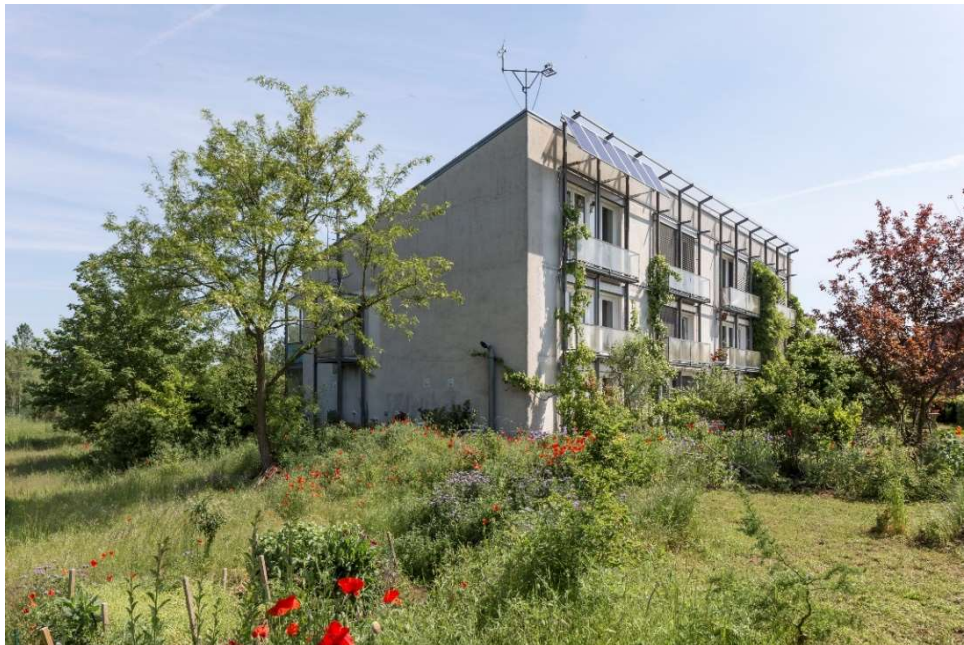
Abbildung 5: An der Westseite des Passivhaus Darmstadt Kranichstein befindet sich ein kleiner Balkon und die Zugangsleiter zum Dach. Die Wetterstation auf dem Dach ist gut erkennbar. Die Schiebläden in Einheit IV wurden 2015 durch Jalousien ersetzt, zugleich wurde zusätzlich Photovoltaik installiert (Foto: P. Cook)
