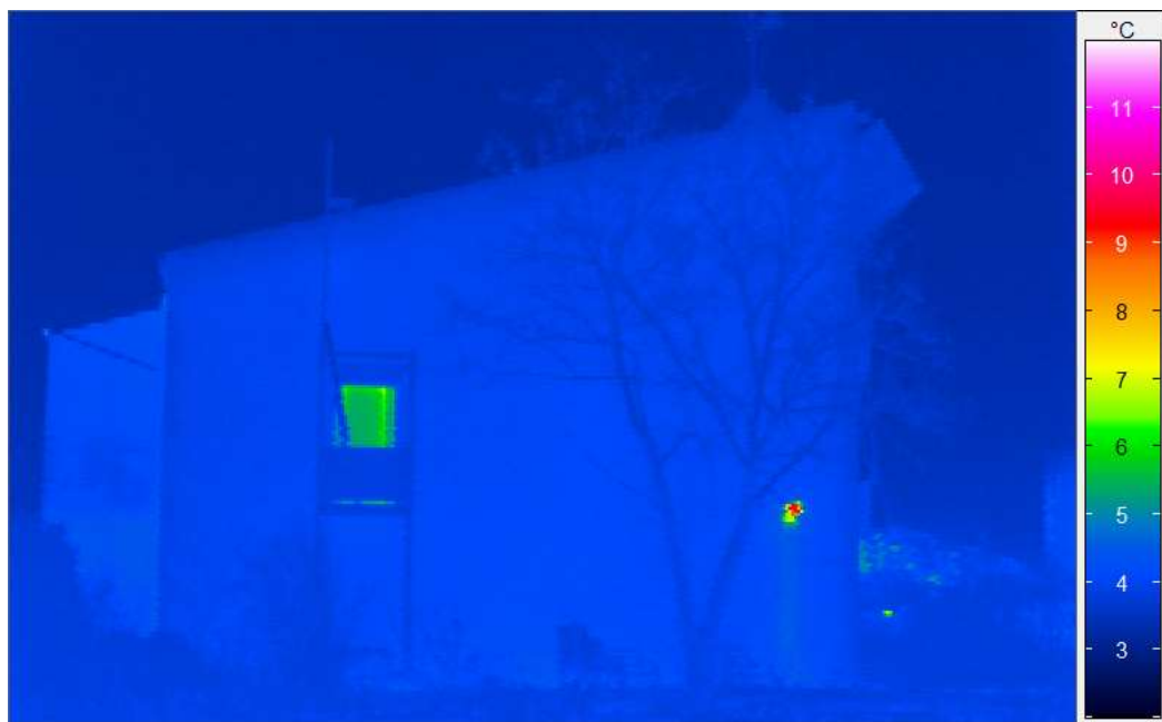
Abbildung 45: Thermographie der Westfassade vom 01.01.2016. Durch den bedeckten (und damit weniger kalten) Himmel entfallen hier die auffälligen Reflexionseffekte gegenüber der Aufnahme von 2001. Weiter erkennbar sind der Fortluftauslass (roter Fleck) und das Nachbargebäude im Hintergrund. Entfallen ist der Schiebeladen. Oben rechts an der Fassade blickt man hinter die neu installierte Photovoltaikanlage. Vor der Fassade ist ein Baum hochgewachsen. Für die gedämmte Fassade, die Anschlüsse zum Dach, die Integration des Fensters zeigt das Bild in der gesamten Fläche eine vollständig homogene Temperatur: Es gibt keinerlei Hinweise auf Wärmebrücken (keine Setzungen, Abrisse o.ä.) oder veränderte Materialeigenschaften.
