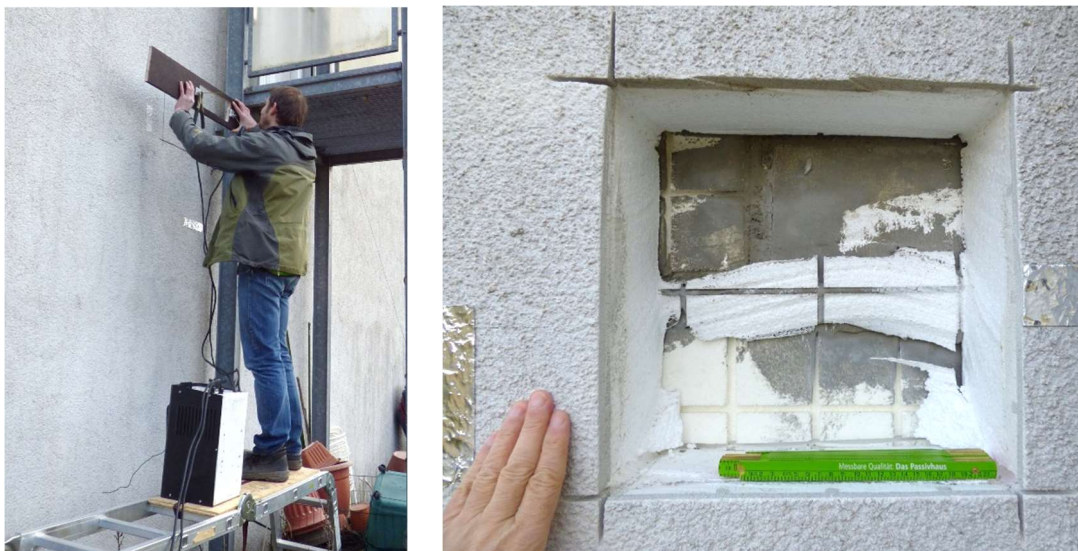
Abbildung 29: Entnahme einer Probe aus dem WdVS. Mit einem Thermoschneidegerät (links) wird die Probe freigeschnitten. Entnommen wurde die äußere Lage der zweilagigen Dämmschicht inkl. der gesamten Außenputzschicht. Das verbliebene Loch in der Fassade (rechts) zeigt die Gitterstruktur (Nuten) der nachfolgenden inneren Dämmschicht. Nach der Entnahme wurde die Fehlstelle temporär mit Dämmwolle gefüllt und verklebt.
