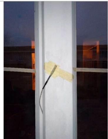
Abbildung 69: Visuelle Aufnahme zur nebenstehenden Thermographie.
