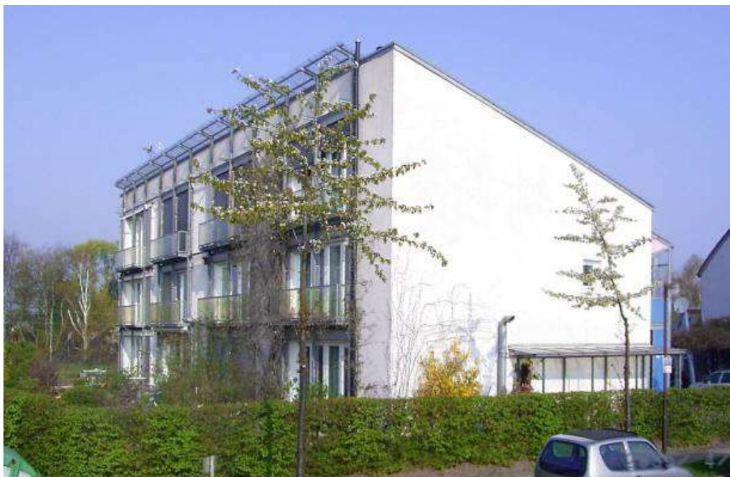
Abbildung 7: Passivhaus Darmstadt Kranichstein, Ansicht von Südosten : In der straßenseitigen Giebelwand gibt es nur ein kleines Ost-Fenster im OG. Gut erkennbar: Der Fortluftauslass und der überdachte zentrale Zugang zum Gemeinschaftskeller.
