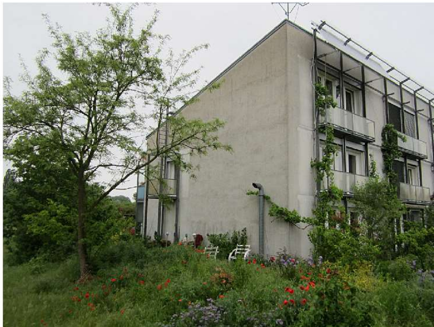
Abbildung 1: Westseite des Objektes Carsonweg 82 in Darmstadt
