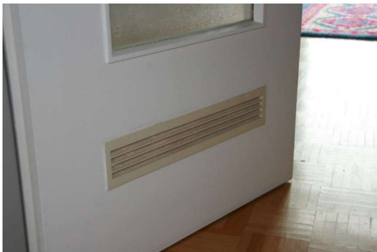
Abbildung 131: Überströmöffnung in der Tür eines Zulufrumes. Der Druckverlust ist kleiner als 1 Pa.
