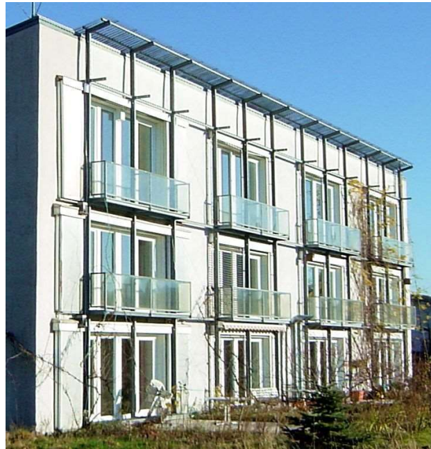
Abbildung 47: Visuelle Aufnahme der Südfassade zur Thermographie im Januar 2001
